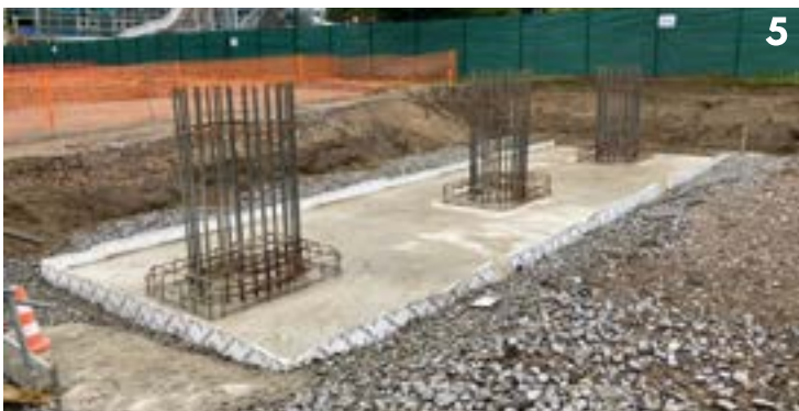
Ferrailage des fondations de l'ouvrage secondaire (Ph 3 et 4). Bétonnage des fondations avec amorces des armatures des piles (Ph 5).
