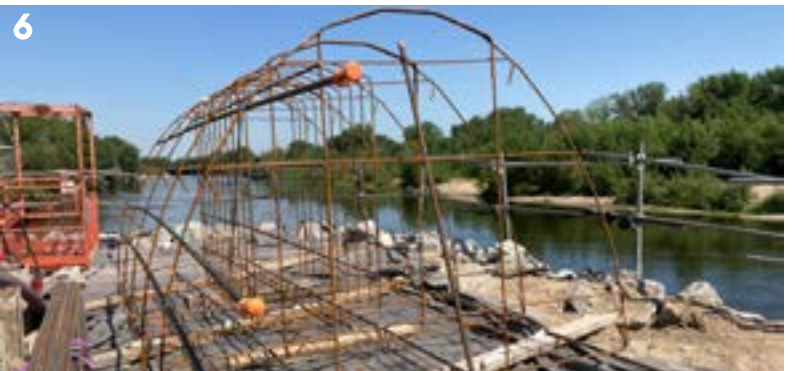
Ferrailage de la pile : Les armatures métalliques sont assemblées directement sur place. Elles constituent le squelette des piles de soutien du deuxième pont. Certaines font près de 4 cm de diamètre. (Ph 6 et Ph 7).
