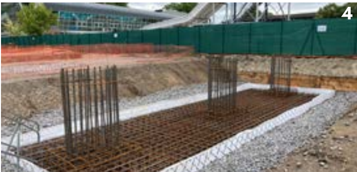
Ferrailage des fondations de l'ouvrage secondaire (Ph 3 et 4). Bétonnage des fondations avec amorces des armatures des piles (Ph 5).
