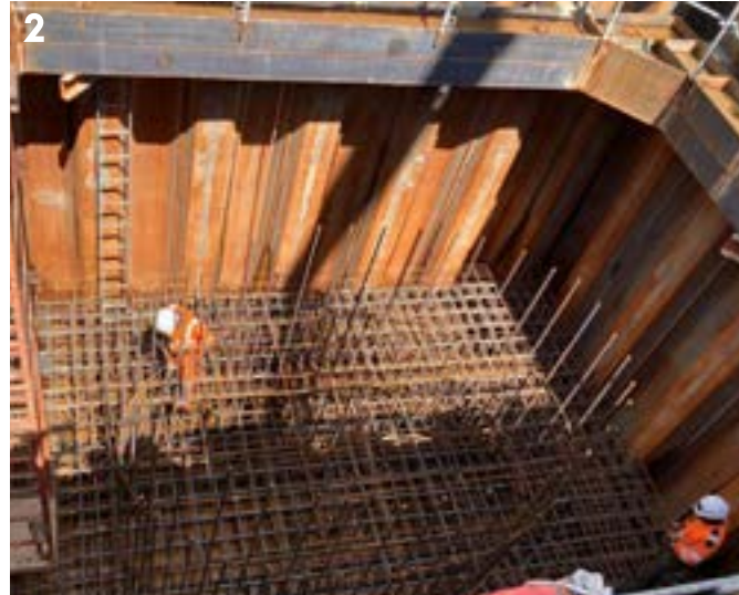
Ferrailage de la pile : les ouvriers travaillent à l'intérieur du batardeau. L'appui de cette partie du pont est différent car il est immergé dans la rivière, et il doit donc être renforcé en conséquences (Ph 2).
