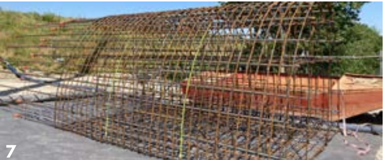
Ferrailage de la pile : Les armatures métalliques sont assemblées directement sur place. Elles constituent le squelette des piles de soutien du deuxième pont. Certaines font près de 4 cm de diamètre. (Ph 6 et Ph 7).
