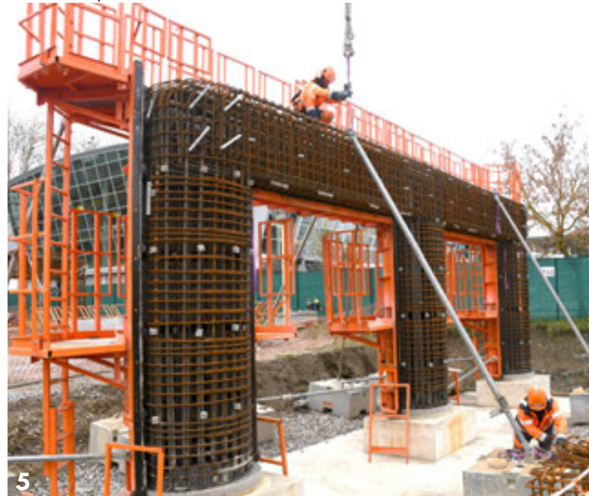
Photo 3 : Ce coffrage constitue le "chevêtre" des piles du viaduc. Il s'agit de la partie supérieure qui portera la structure du pont. Photo 4 et 5 : Les appuis de l'ouvrage secondaire sont presque terminés. Photo 6 : La pile P2, deuxième pile du viaduc, en cours de construction.
