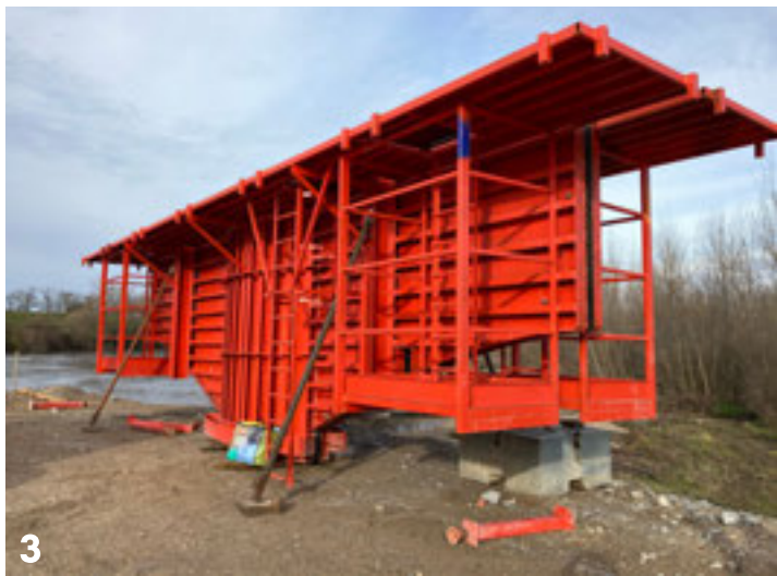
Photo 3 : Ce coffrage constitue le "chevêtre" des piles du viaduc. Il s'agit de la partie supérieure qui portera la structure du pont. Photo 4 et 5 : Les appuis de l'ouvrage secondaire sont presque terminés. Photo 6 : La pile P2, deuxième pile du viaduc, en cours de construction.
