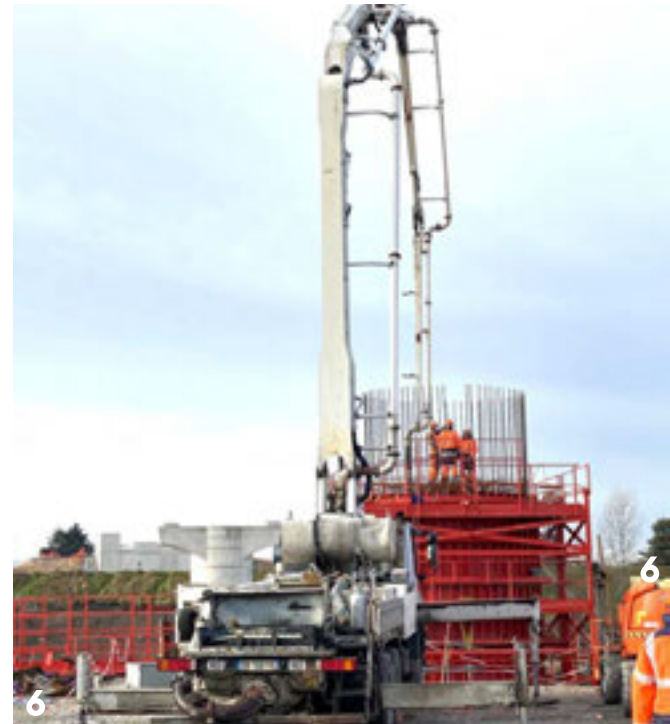
Photo 3 : Ce coffrage constitue le "chevêtre" des piles du viaduc. Il s'agit de la partie supérieure qui portera la structure du pont. Photo 4 et 5 : Les appuis de l'ouvrage secondaire sont presque terminés. Photo 6 : La pile P2, deuxième pile du viaduc, en cours de construction.
